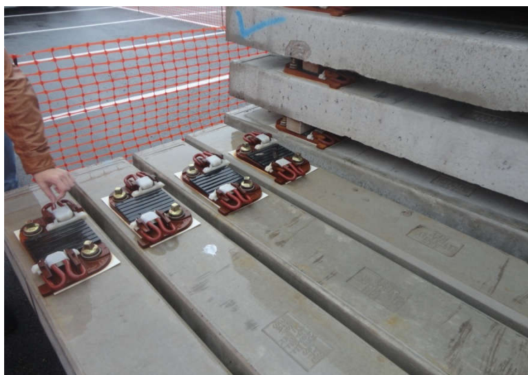
Рисунок 2.3 – Организация места складирования железобетонных брусьев при снаряжении путеукладочного поезда раздельной укладки
