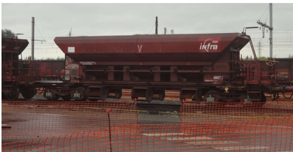
Рисунок 1.6 – Организация рабочего места при снаряжении путеукладочного поезда раздельной укладки на железной дороге во Франции
