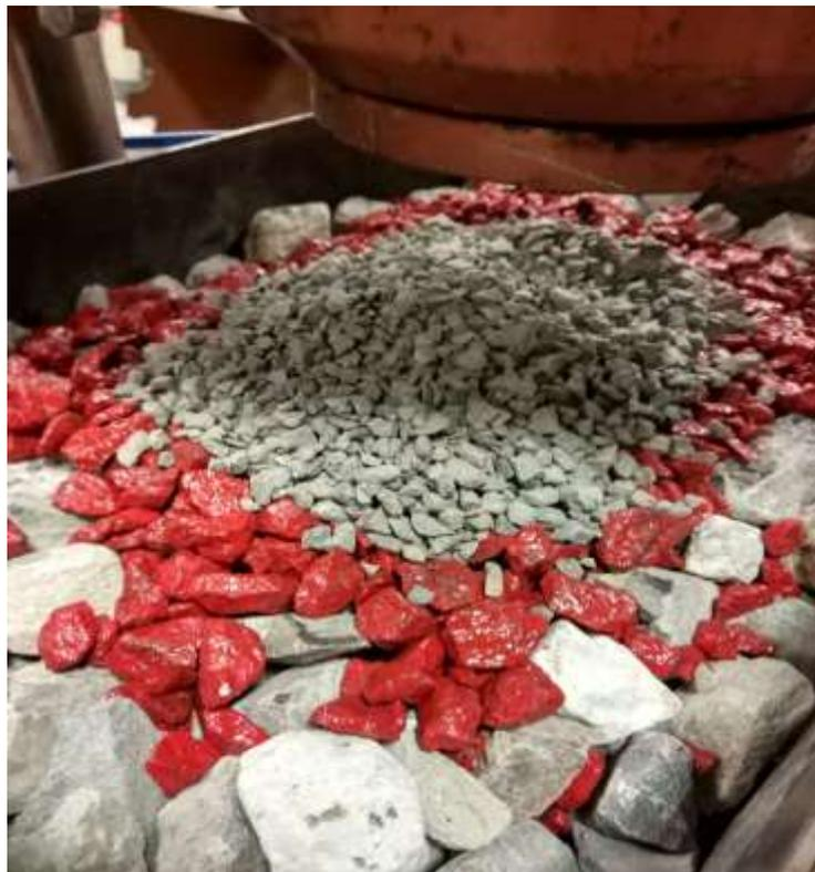
Рисунок 2.14 - Отсыпка слоя фракции 5-10 мм поверх щебня фракции 10-20 мм.
