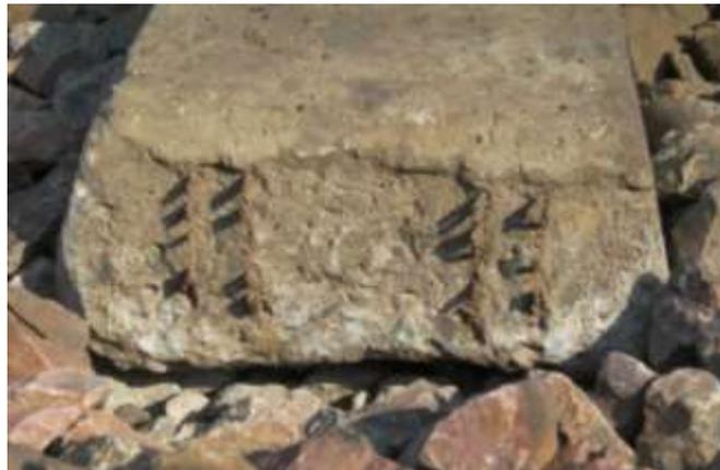
Рисунок 3.7 - Раскопанная скрытая просадка 25 мм под шпалой
