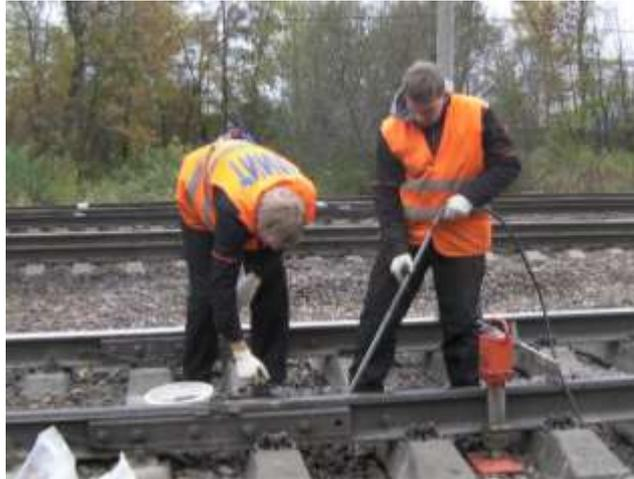
Рисунок 3.3 - Выправка пневматическим суфляжем
