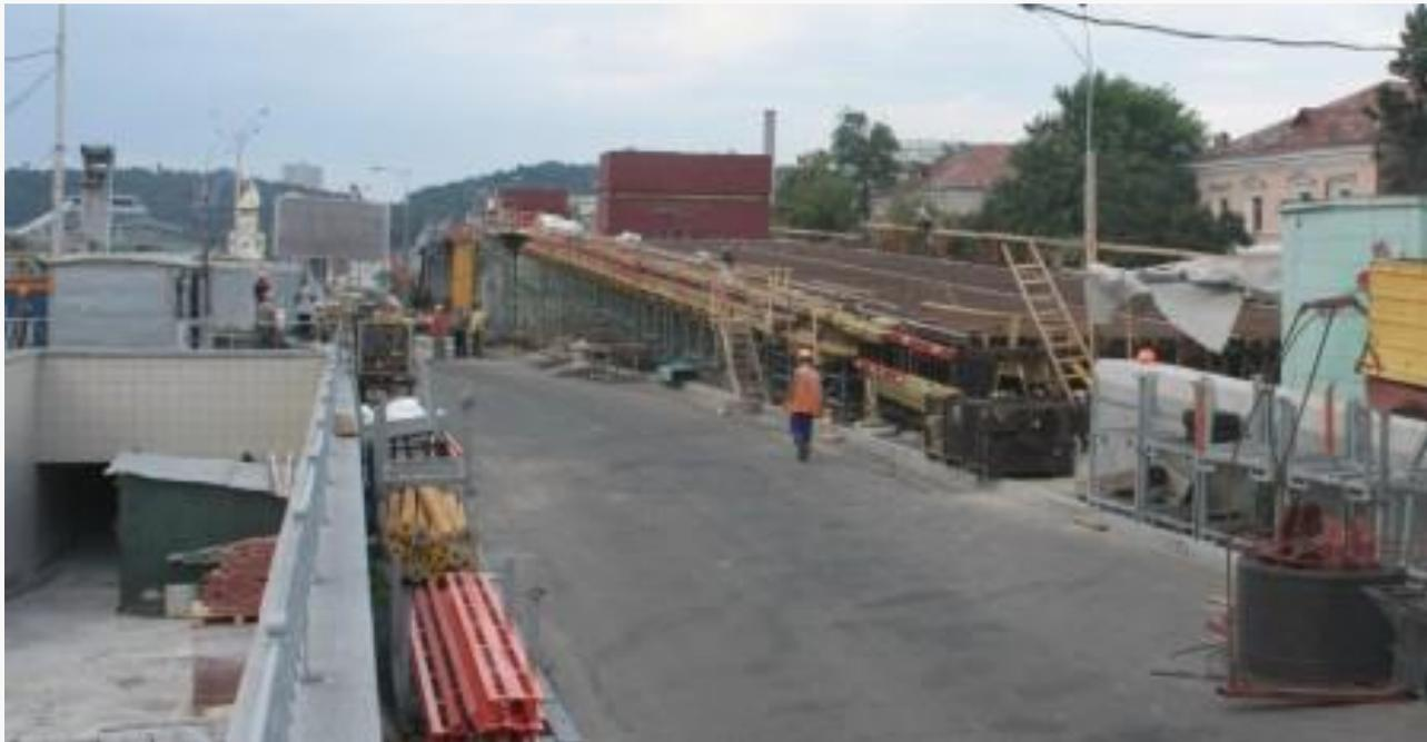
На пролетном строении установлены понтоны с водой для увлажнения уложенного бетона
