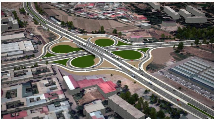
Часто при плотной застройке используется компактный вариант клеверного листа: «diamond interchange». Она отличается более сжатыми лепестками, предназначенными для перехода с одного направления на другое.
