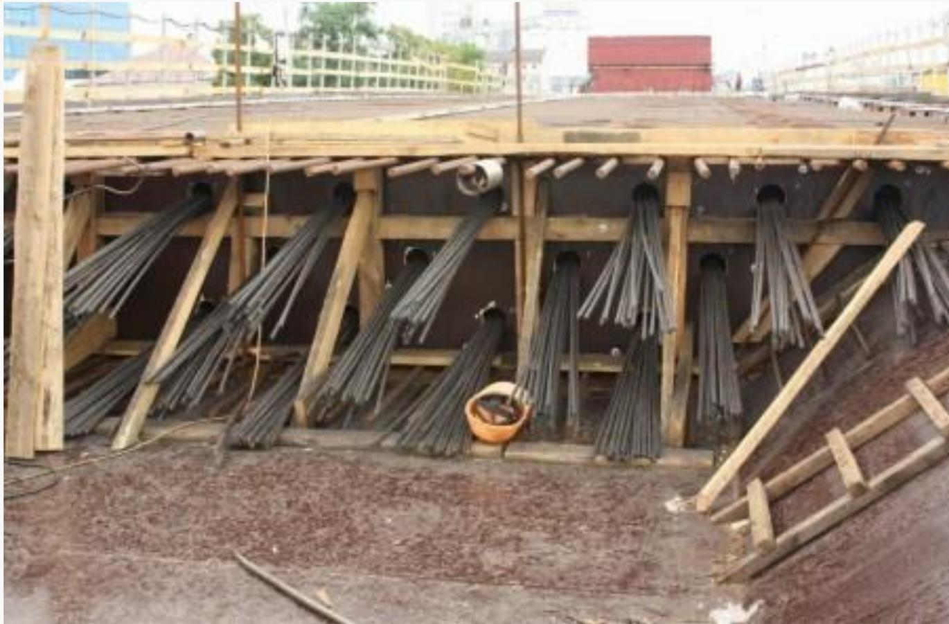
Захваток на этой эстакаде всего 5 =>  $48 + 66 + 66 + 81 + 48 = 309$  м, на фото показана захватка длиной 66 метров. Захватка это участок пролетного строения который бетонируется за один прием
