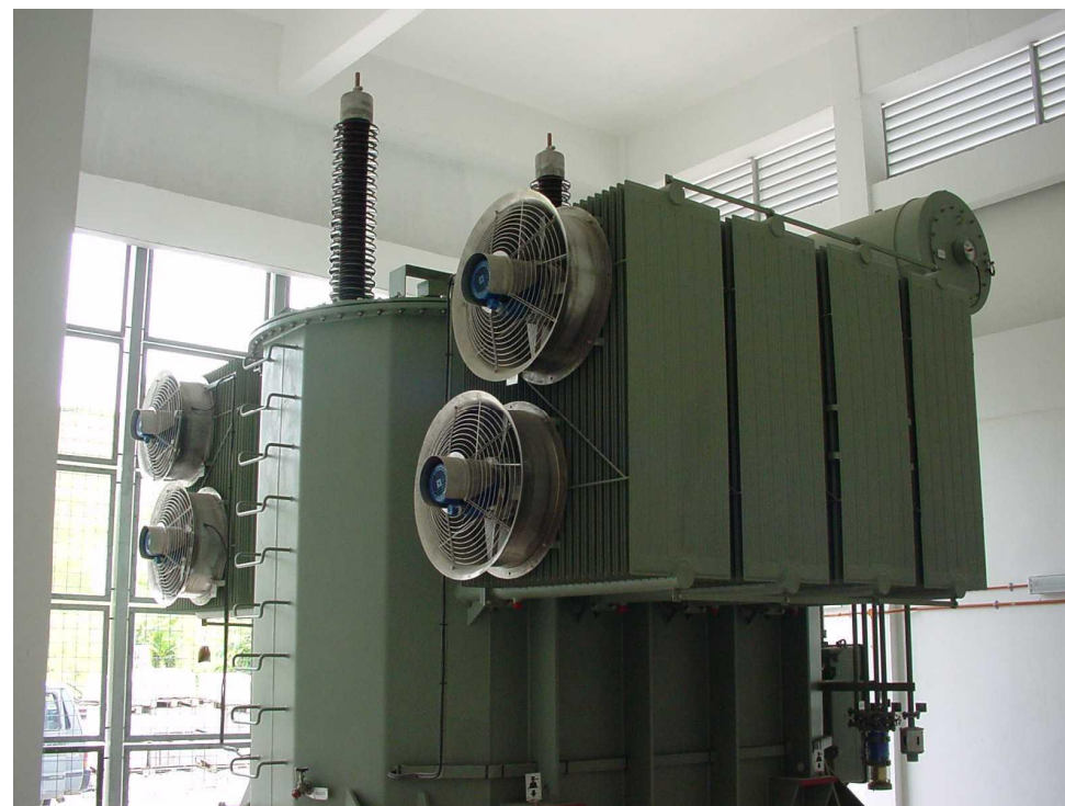
Однофазный тяговый трансформатор с масляной изоляцией 110/27,5 кВ
