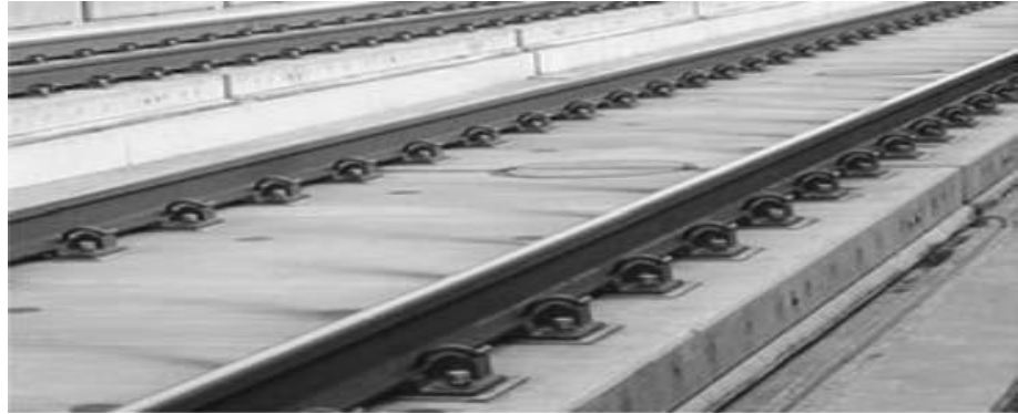
Рисунок 1.22 Конструкция железнодорожного пути без балласта
