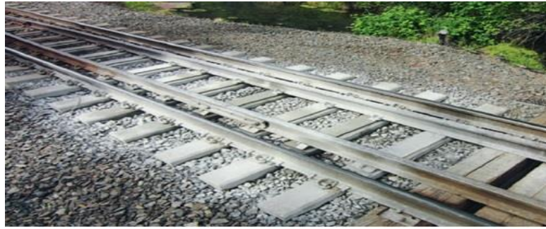
Рисунок 1.13 Образование предмостовой ямы из-за дробления балласта (справа внизу – начало моста) [Optimisation of Transition Zones, Раздел 2. Compensating for Deflection Differences, https://www.getzner.com/en/latest-news/news/new-brochure-optimisation-of-transition-zones-published ]
