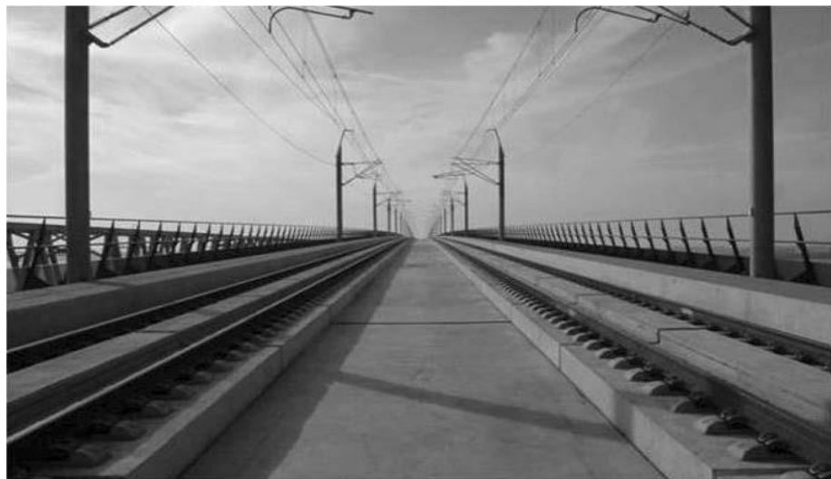
Рисунок 1.7 Система RHEDA 2000 на мосту через Hollandsch DIEP.
