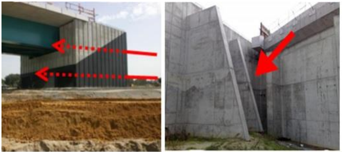
Рисунок 1.19 Обсыпной устой значительной протяженности для сдерживания остаточных деформаций.
